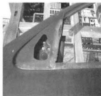
(b) 冷轧板车门门框的锈蚀
