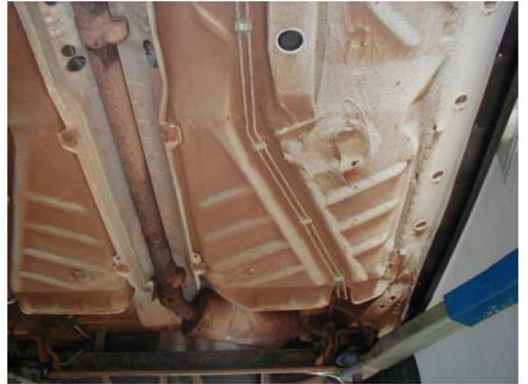
有 PVC 涂层，底板未出现腐蚀
